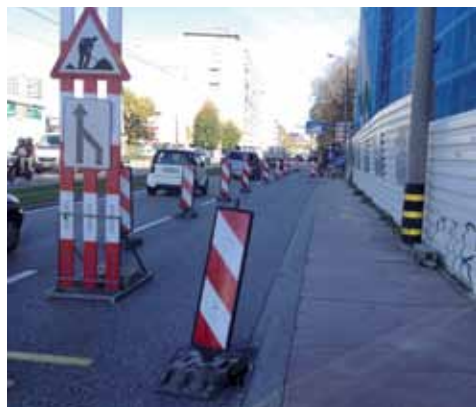
Route de Saint-Julien: une voie est aménagée pour sécuriser les déplacements à vélo
